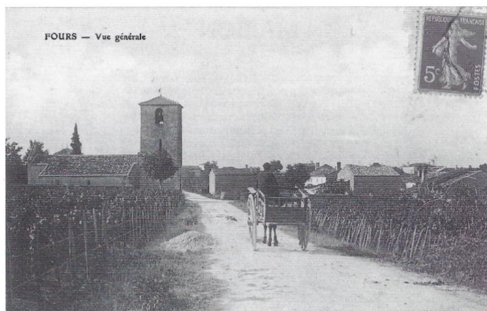
Fours : une vue générale
